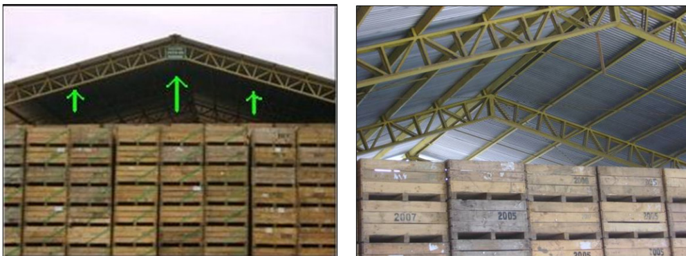
Figura 2.1. Distancia entre los bins superiores y el techo del galpón para permitir una adecuada circulación de aire.
